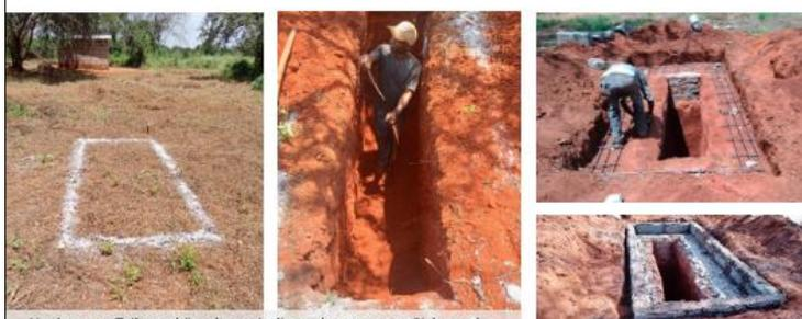
Neubau von Toilettenhäuschen mit diesmal gemauertem Sickergrube
