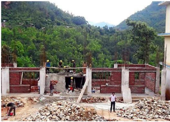
Ein Teil des Schulkomplexes der Shree Bageshwore Higher Secondary School in Malekhu wurde vor zwei Jahren durch die Erdbeben zerstört. Ein Neubau mit vier Klassenzimmern soll diesen Gebäudeteil ersetzen. Die Kinder bekommen dort eine durchgehende Hauptschulbildung bis zur zehnten Klasse.
