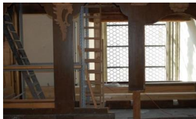
Auf der Orgel-Empore wird eifrig gearbeitet.
